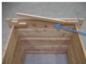
**Etape N°3 :** Disposer les planches de support de couvercle (tasseaux orientés vers l'intérieur du composteur).
